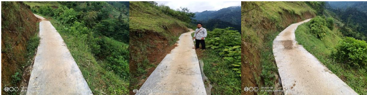
Gambar 6. Kondisi akses jalan menuju Curug Segerenjeng yang setelah dibeton
