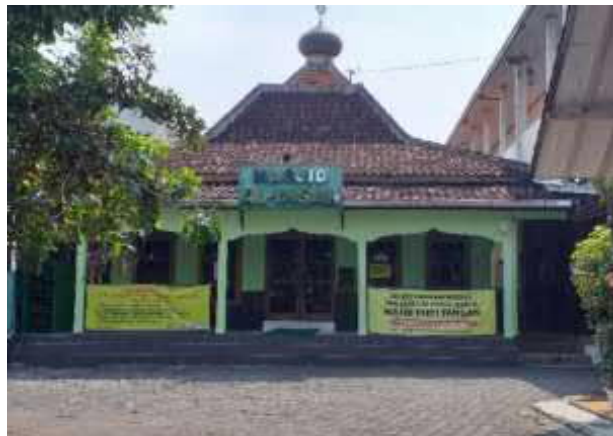
Gambar 2. Fasilitas/Kondisi Masjid Sebelum Dibuat dan Dilaksanakan SOP
