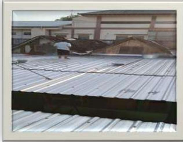
Gambar 2 : Perbaikan fisik atap dan genteng galvalum
