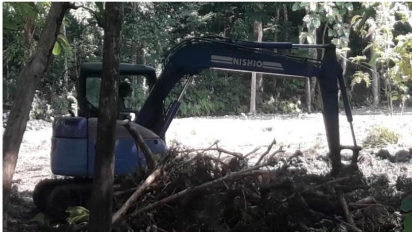
**Gambar 5. Ekskavator Digunakan untuk Meratakan Tanah, Memindahkan Material, dan Galian Fondasi**
