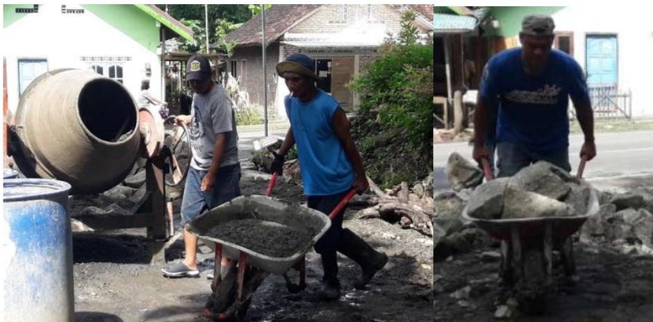
**Gambar 6. Peralatan yang Digunakan untuk Membuat Adukan dan Mengangkutnya**
