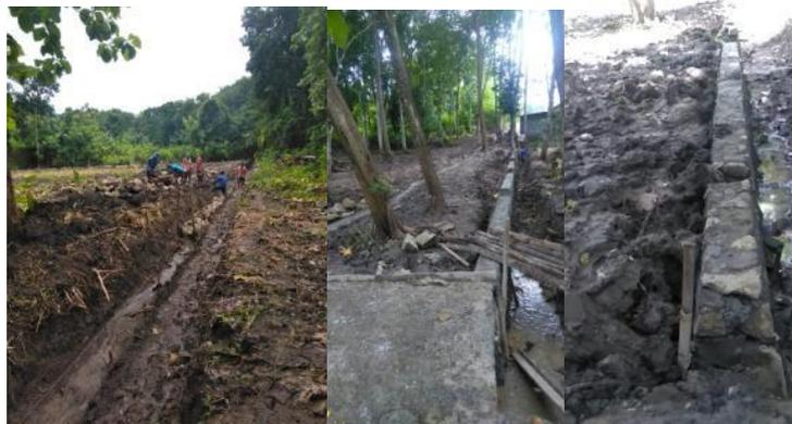
Gambar 13. Hasil Perataan Tanah dan Pemasangan Fondasi Pagar Keliling
