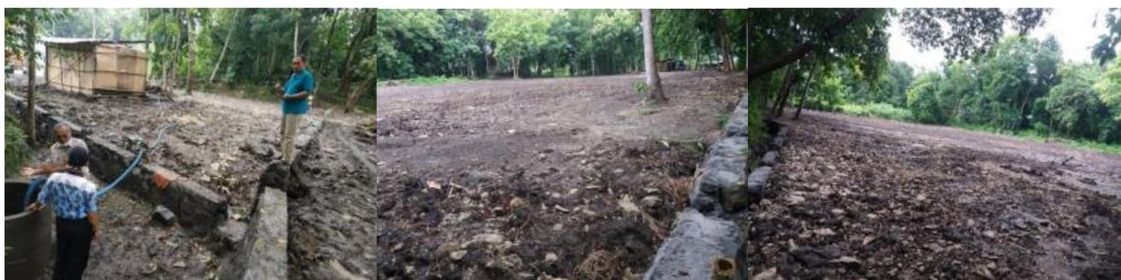
Gambar 14. Hasil Perataan Tanah dan Pemasangan Fondasi Pagar Keliling
