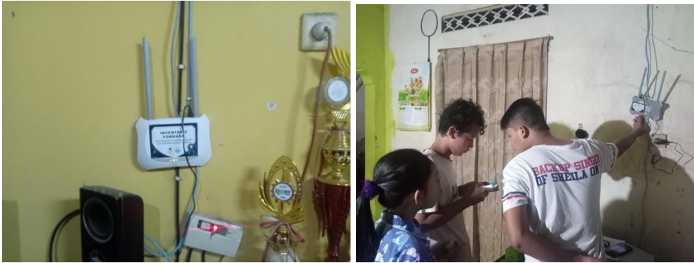
Gambar 3. Dokumentasi Pemasangan Infrastruktur
