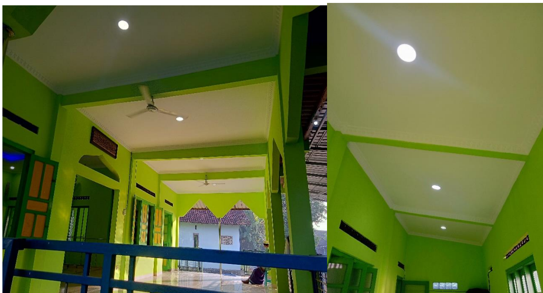
Gambar 8. Hasil Pemasangan Plafon dan Pengecatan di Ruang Pawastren dan Serambi masjid
