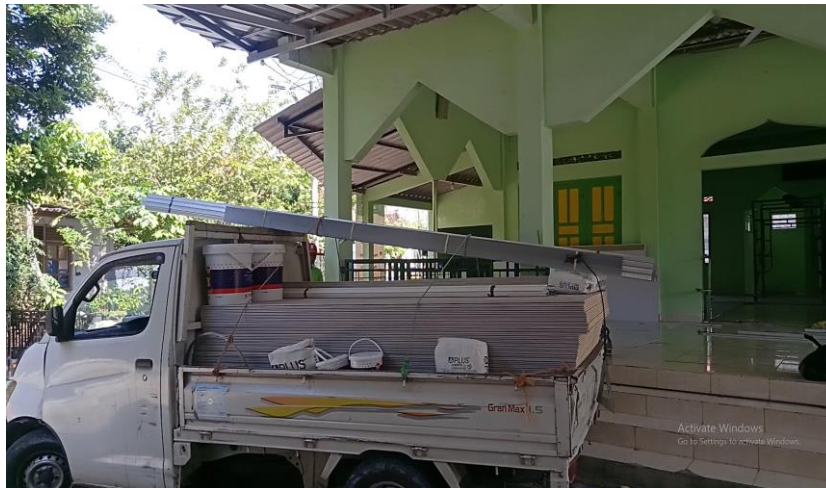
Gambar 3. Pembelian Material Cat, Gypsumbord , List Gypsum , Lampu Rangka Baja Ringan Hollow 4x4 dan 2x4 untuk Pemasangan Plafon di Ruang Pawastren dan Serambi Masjid Al Anwar
