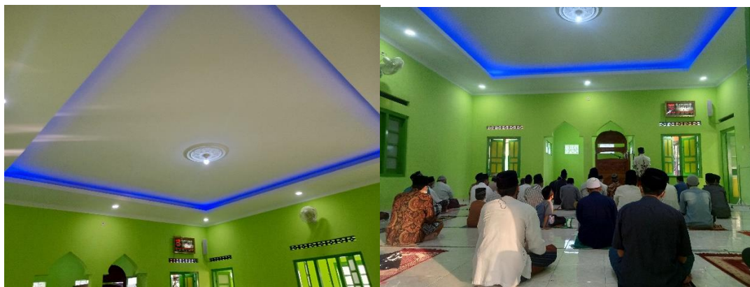
Gambar 9. Hasil Pemasangan Plafon dan Pengecatan di Ruang Utama Masjid.
