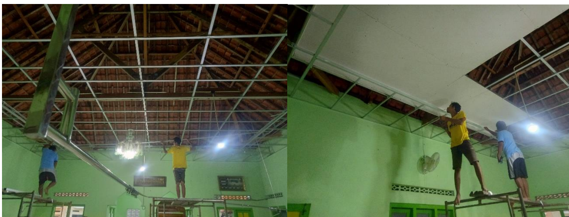
Gambar 3. Pemasangan Rangka Baja Ringan Hollow 4x4 dan 2x4 Sebagai Rangka Pemasangan Gypsumbord Pada Ruang Utama Masjid
