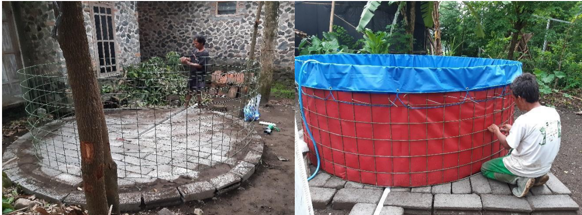
Gambar 3. Pemasangan Kolam Terpal bulat Diameter 3 meter
