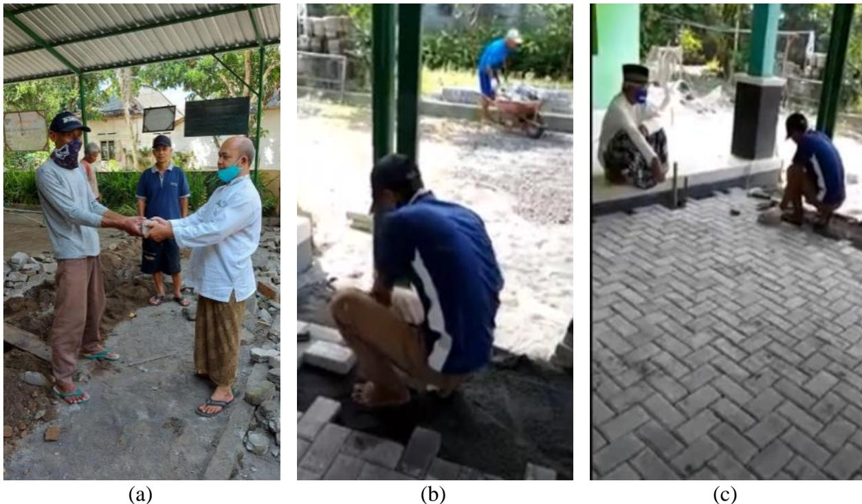
Gambar 5. Proses pavingisasi, (a) Sekretaris PPL Mukti Mulia menyatakan dimulainya pekerjaan pavingisasi, (b) Tukang yang sedang memasang *paving block*, (c) Supervisi pekerjaan oleh ketua PPL Mukti Mulia
