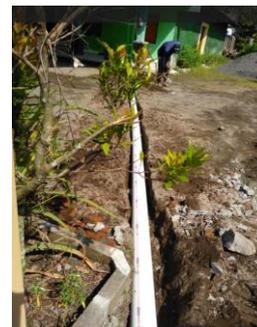
Gambar 4. Pemasangan pipa drainase.
