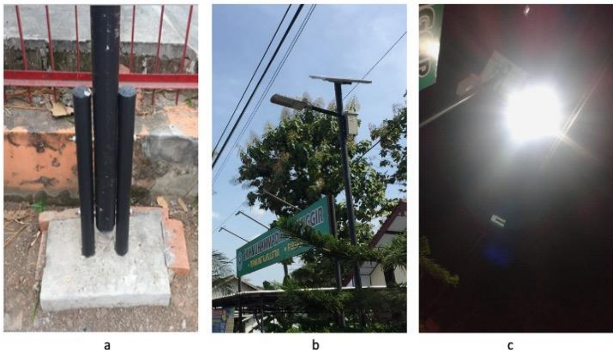
Gambar 8. (a) DFondasi PJU, (b) PJU terpasang, (c) Pengujian PJU sampai dengan jam 20.00
