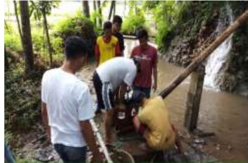
Gambar 3. Instalasi perpipaan, a). bak penampung/pelepas tekanan ke pipa penstock, b). penstock ke pompa hidram
