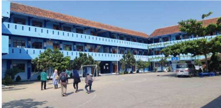
Gambar 1. Gedung Sekolah Santri Putra MBS Prambanan
