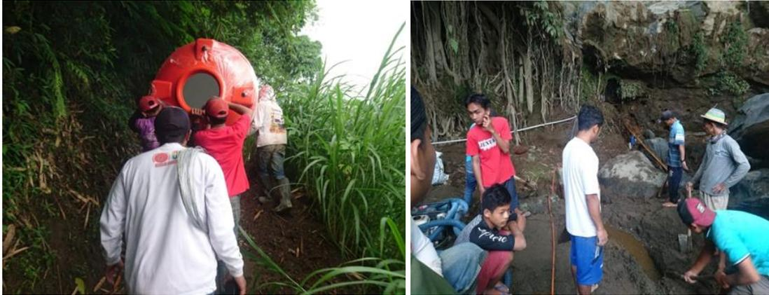
Foto pemasangan instalasi air bagian atas sebagai penampungan air dari pemompaan dari sumber air sehingga dapat dimanfaatkan oleh warga bagian atas sumber air sejauh 250 meter.
