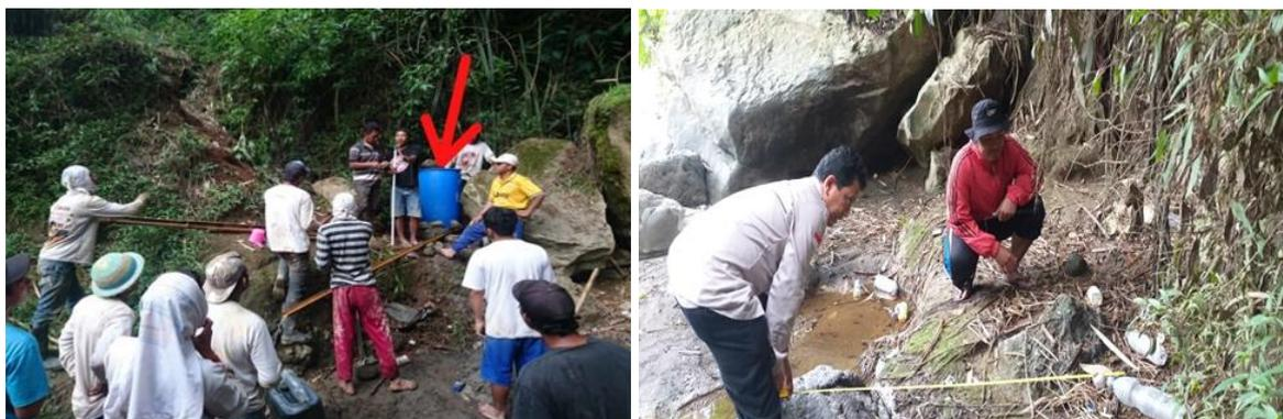
Foto pemasangan instalasi air bersih yang terdiri atas tangki air dan 2 pompa air Sanyo untuk menaikkan air ke rumah warga dari sumber air sedalam 56 meter dan foto DPL (pengabdian) saat mengukur rencana instalasi di sumber air.
