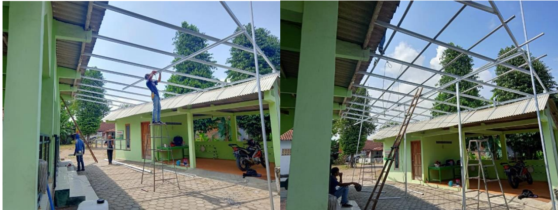
Gambar 1. Pemasangan rangka atap baja ringan
