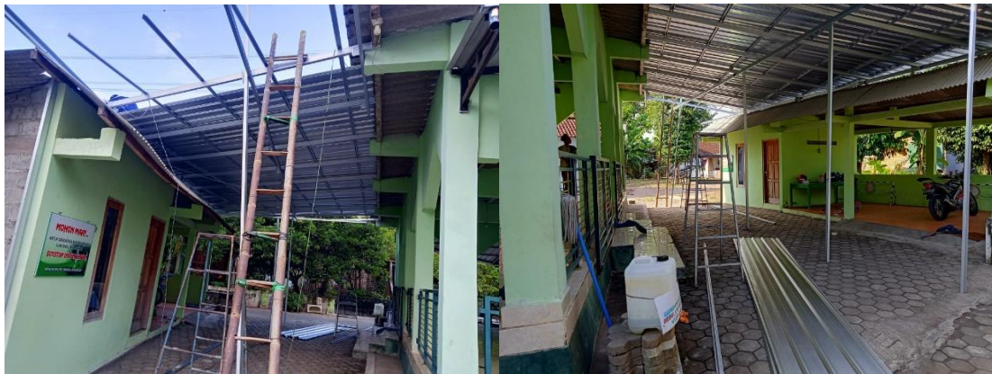
Gambar 2. Pemasangan elemen penutup atap baja ringan
