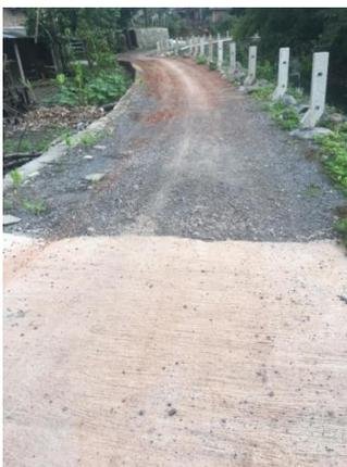
**Gambar 2.** Kondisi jalan yang sudah dicor dan yang belum, serta belum ada pagar pembatas dengan tebing sungai.
