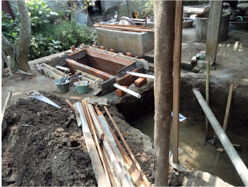
Gambar 7 Tahap Pembangunan Fisik IPAL
