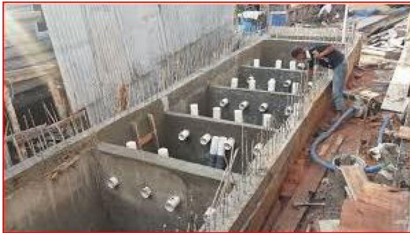
Gambar 10 Proses Pemasangan IPAL dan Filter
