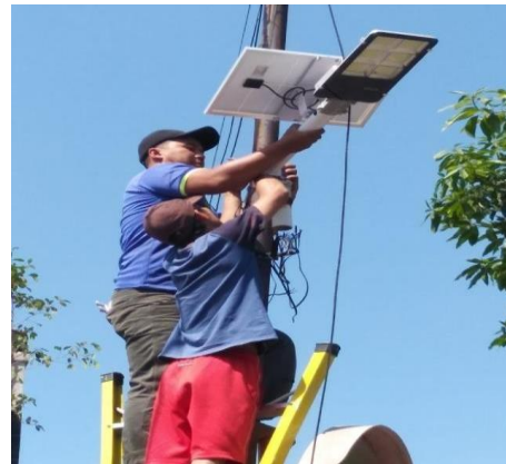
Gambar 6 Pemasangan lampu penernag jalan tenaga surya
