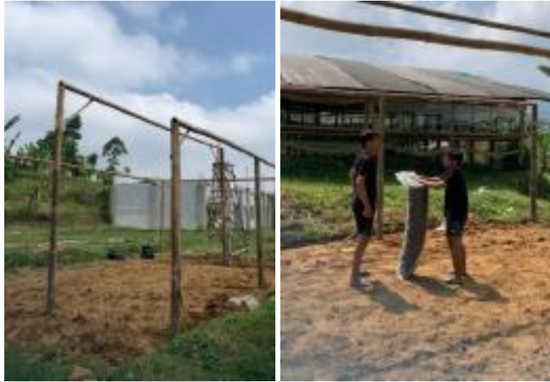
Gambar 3. Pembangunan kerangka greenghouse
