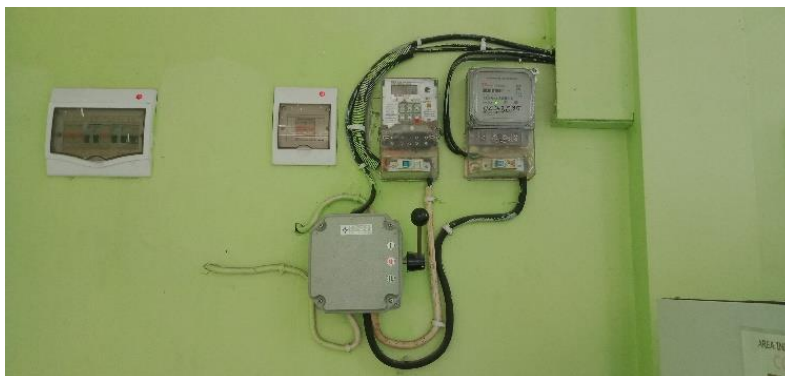
Gambar 2. Saklar Togel Pengubah Sumber Daya Listrik
