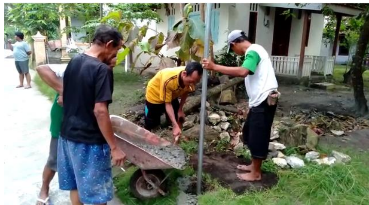
Gambar 4. Kerja bakti pemasangan lampu penerangan
