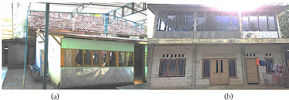
Gambar 3. (a) Bangunan PA Muhammadiyah Ahmad Sudjari (a) sebelum direnovasi, (b) setelah direnovasi
