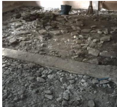
Gambar 8. Pembongkaran lantai konblok
