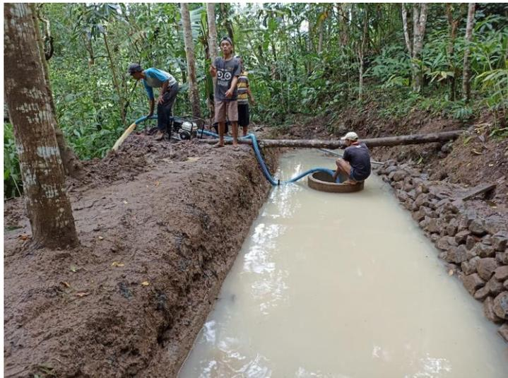
Gambar 6. Hasil konstruksi dan pembuatan sumur pada sumber air
