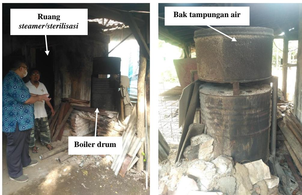
Gambar 2. Keadaan boiler untuk proses sterilisasi yang dimiliki mitra
