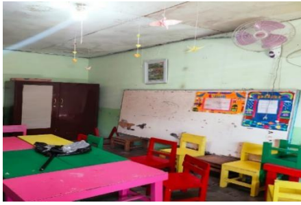
Kelas sebelum renovasi
